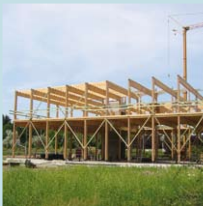
Het natuurcentrum is opgetrokken in houtskeletbouw waardoor je gemakkelijk dik kan isoleren.
