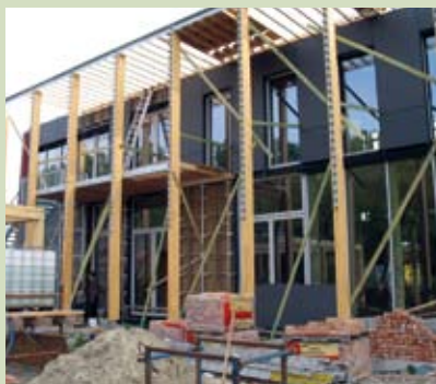
Omdat er meer dan 30 centimeter isolatie in de wanden zit is gekozen voor houtskeletbouw.
