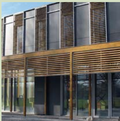
Aan de hoofdingang wordt extra warme lucht ingeblazen.
