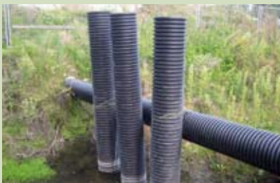
Verse lucht wordt aangevoerd door deze grondbuizen. In de zomer wordt zo het gebouw gekoeld.
