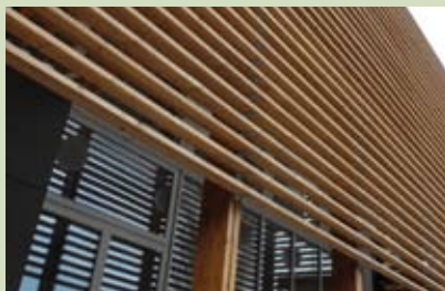
Om oververhitting te voorkomen, bevindt de zonwering zich aan de buitenkant.
