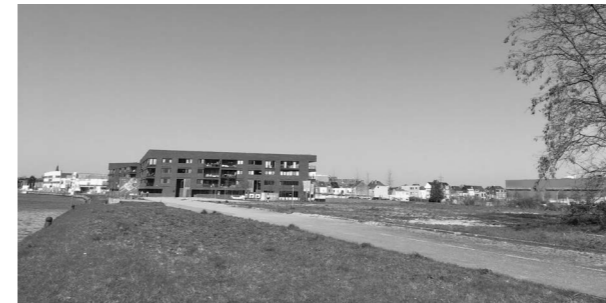
Braakliggend terrein tussen de Zenne en het Kanaal.
